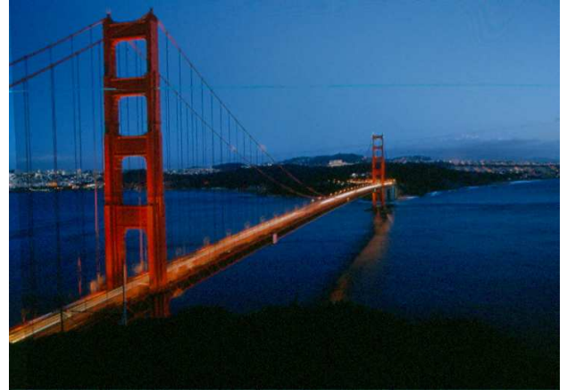
(d) Repaired image - Tier 2
